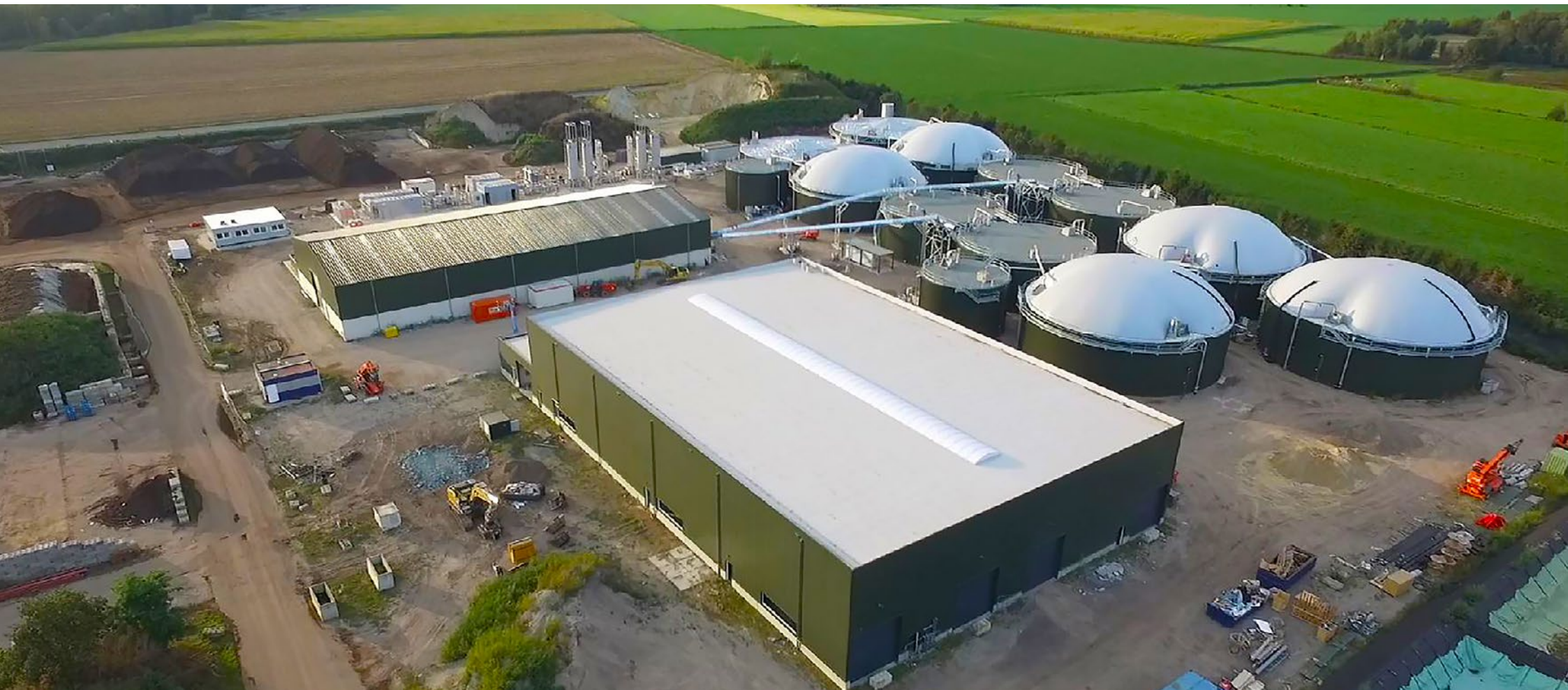
23 Industriële installatie in aanbouw
